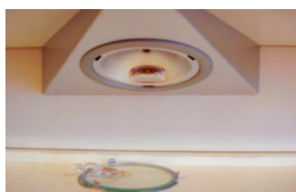
2. Выньте лампу из корпуса светильника, потянув ее вперед.
