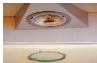
3. Возьмите защищенными руками (в перчатках) новую лампу, поднесите штырями цоколя к патрону и установите ее в патрон.
